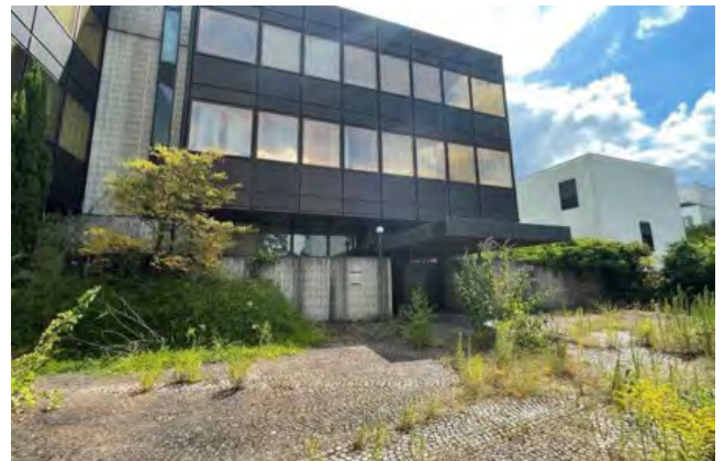
Außenansicht einer ehemaligen Botschaft in Bonn.
